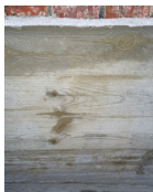
Bild 2 - Möglichkeiten der Farbgebung des verwendeten Holzergänzungsmörtels
